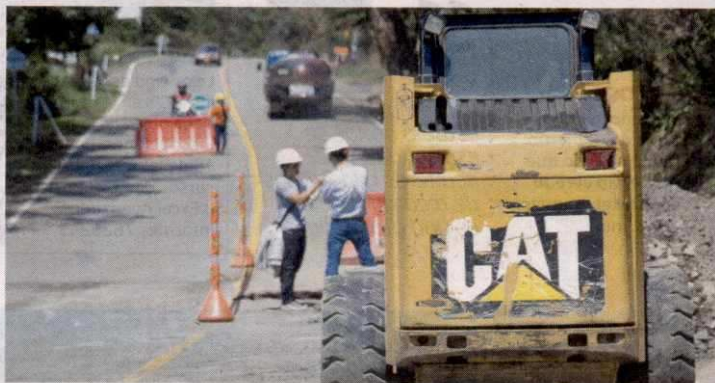
Inicialmente en toda la vía se hará el cambio de tubería de las alcantarillas y la construcción de box culverts.
